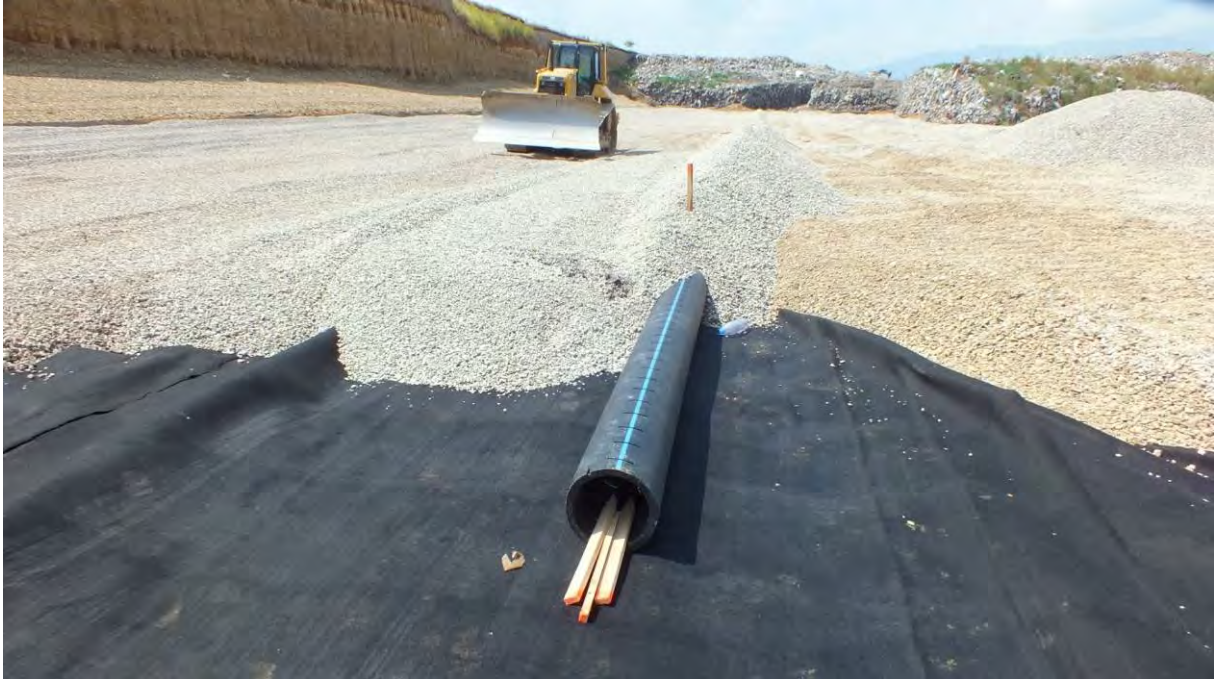
4. ábra. A Törtkő-rétegbe helyezett dréncső
