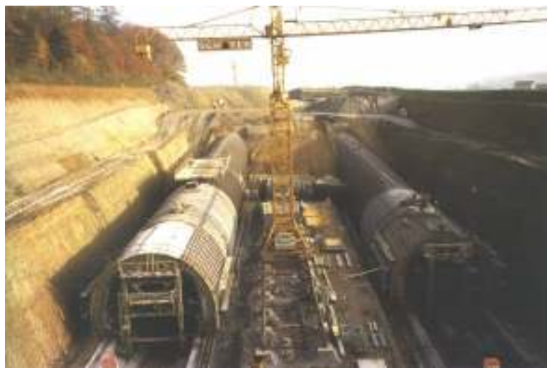
11.8. ábra. Alagútépítés „cut and cover” eljárással.
