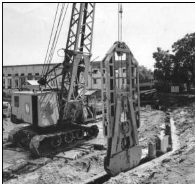
8.10. ábra. Kötélfüggesztésű, réskészítő markológép.
