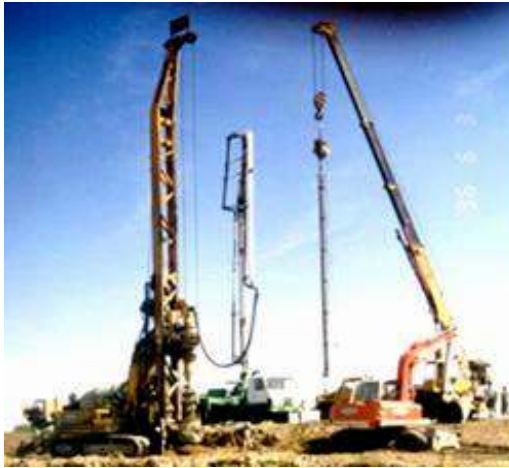
7.5. ábra. CFA-cölöpözés (spirálfúrás, talajdugós megtámasztás, betonozás a fúrószáron át nyomás alatt, utólag bevibrált vasalás)
