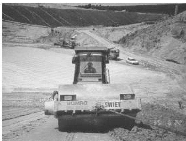
9.2. ábra. Hulladéklerakó szigetelő aljzatának építése geoműanyagok alkalmazásával.
