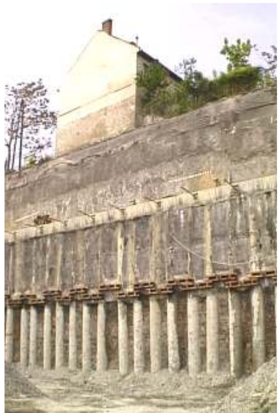
8.13. ábra. Hátrahorgonyozott hézagos cölöpfal részleges lött betontakarással.
