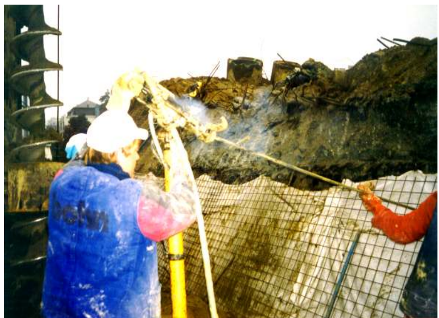
8.24. ábra. Talajszegezés a lött beton alá fektetett textíliával fedett földfalon
