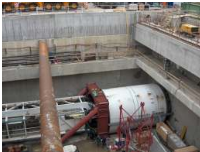
11.26. ábra. Pajzszindítás Kelenföldön.
